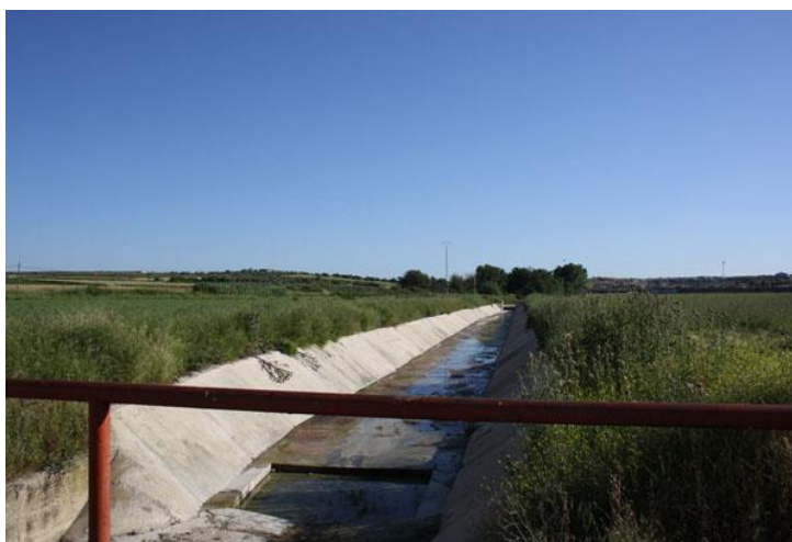
Encauzamiento del Arroyo de la Sal a su paso por el casco urbano.
